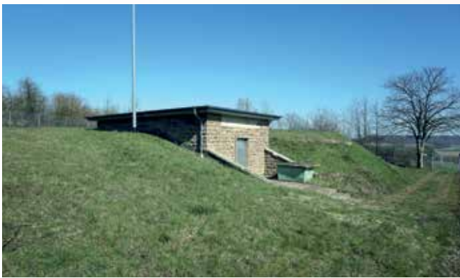
Hochbehälter Sultmer – nahe eines beliebten Spazierweges oberhalb des Galgenbergweges in Northeim. Hier wird eine von mehreren Blühwiesen der Stadtwerke Northeim entstehen.
